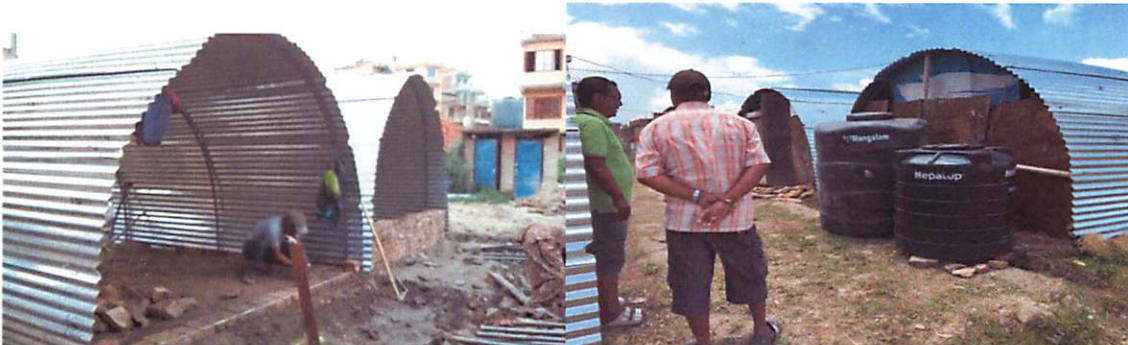
Bau neuer Notunterkünfte hinter unserem Kinderhaus Wasserversorgung der Notunterkünfte
